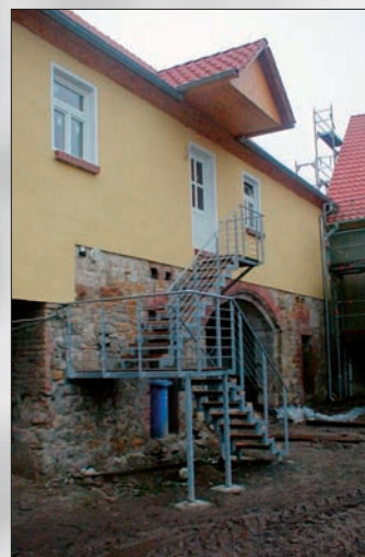
Außentreppen mit Zwischenpodeste
