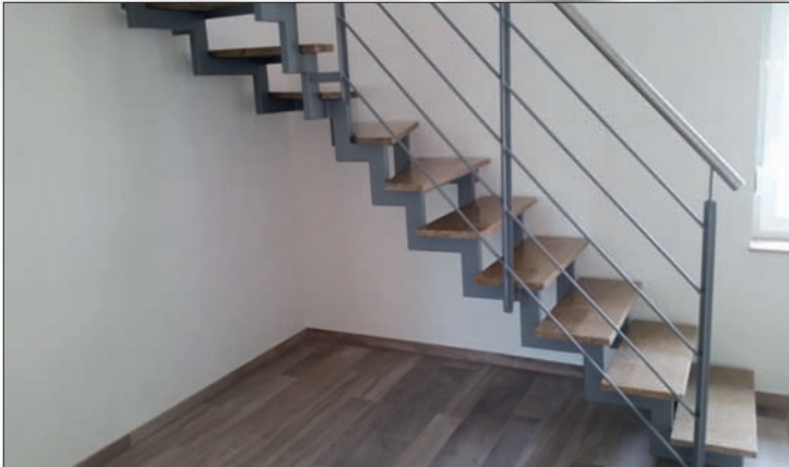
Zweiholmtreppe, Stahl RAL lackiert, Granitstufen
