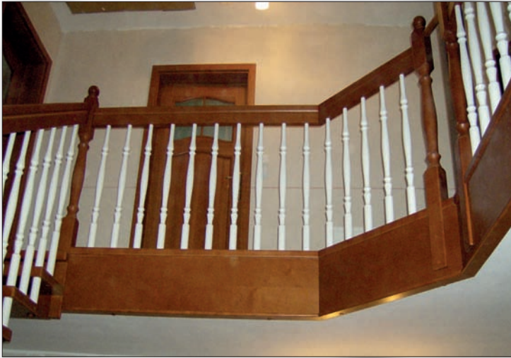
Galeriegeländer mit Deckenblende
