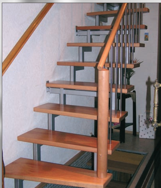
Erdgeschoss, Edelstahloptik mit Buchestufen und schrägen Antritt
