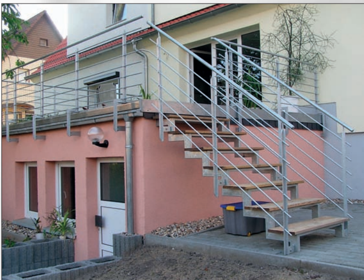
Außentreppe verzinkt mit Terrassengeländer
