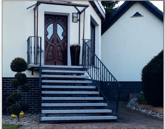
Außentreppe mit Sonderstäben und Granitstufen 8 cm stark
