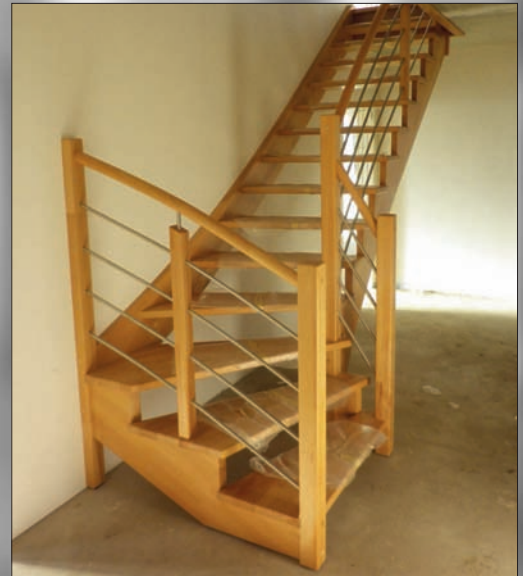
Massivholztreppe eingestemmt-aufgesattelt, Relinggeländer Edelstahl
