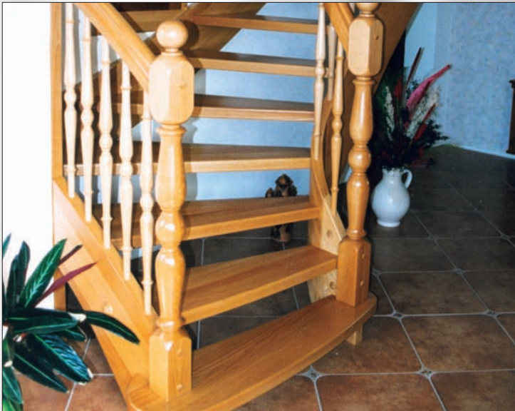
Buchentreppe mit beidseitiger Blockstufe und Krümmling
