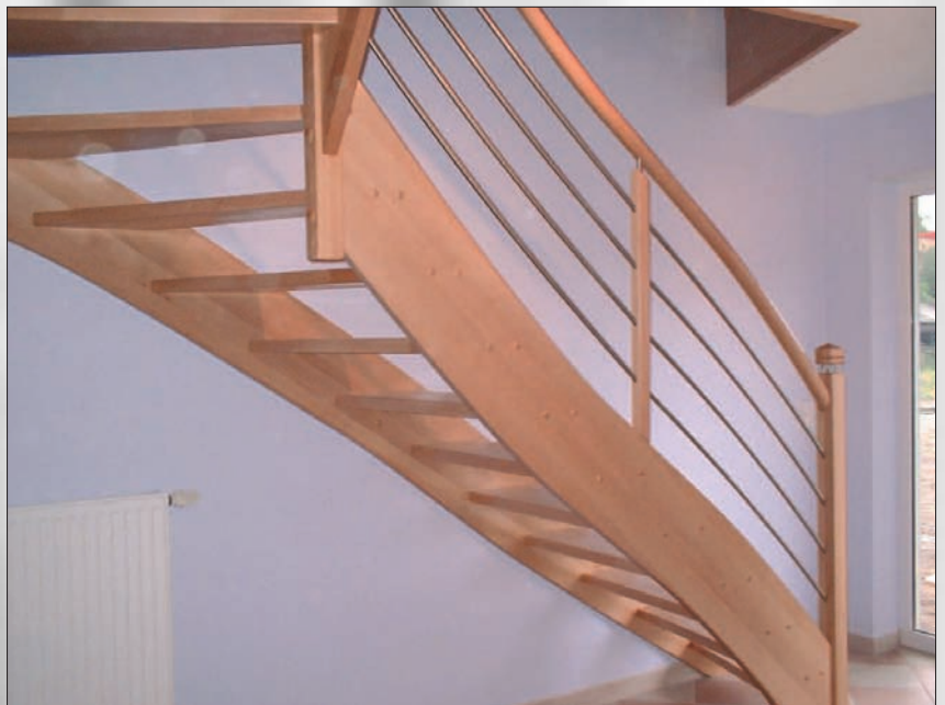
eingestemmte Buchetreppe, mitlaufende Edelstahlstäbe
