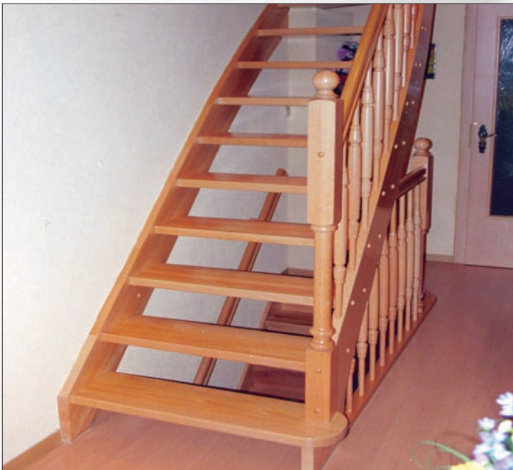
EG – offene Treppe mit Brüstungsgeländer unter Wange
