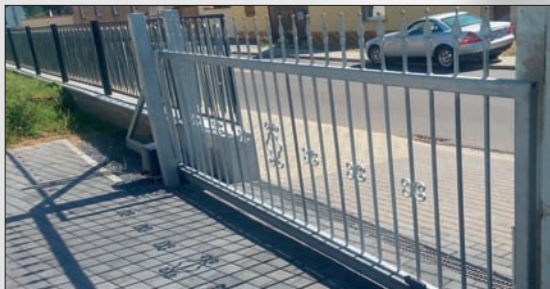
freitragendes Schiebetor mit E-Antrieb
