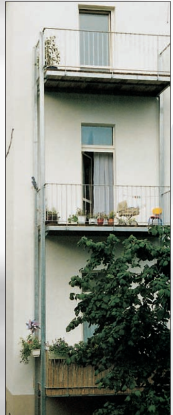
Balkon, Stahl mit Plattenbelag
