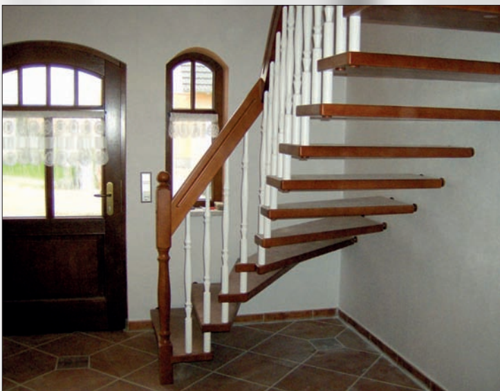
Bolzentreppe nussbaum gebeizt, Stäbe weiß lackiert
