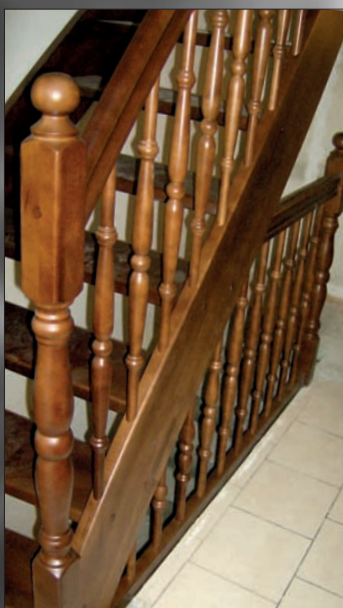
Holzstreppe gebeizt. Brüstungs- geländer unter Wange geführt
