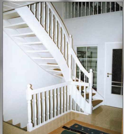
Treppe Esche-weiß mit Brüstungsgeländer
