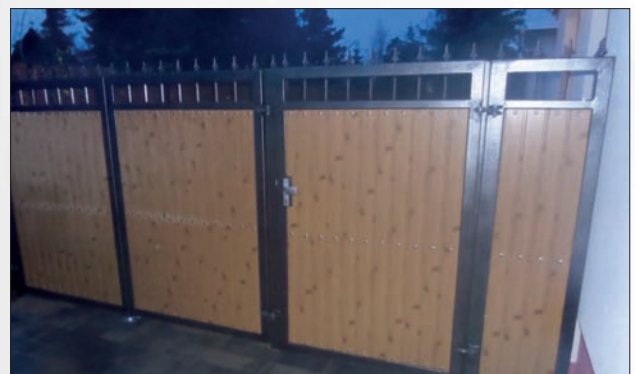
Tor pulverbeschichtet mit Kömpanfüllung
