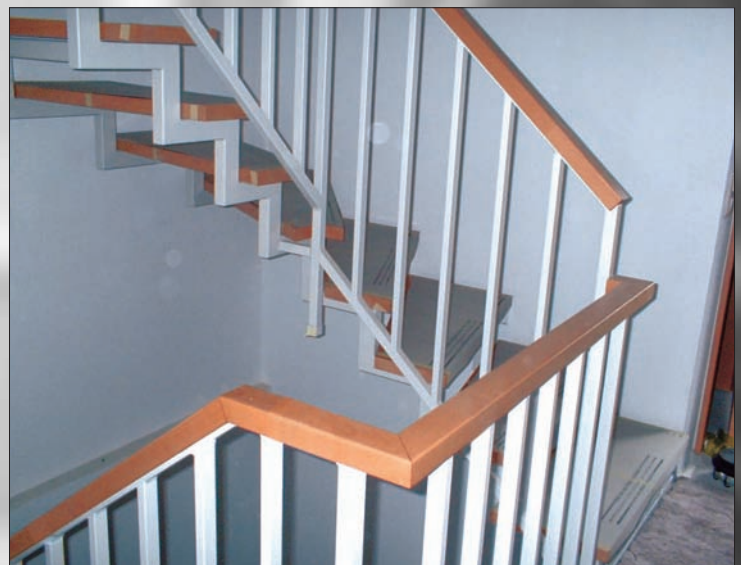
Harfentreppe mit aufgesetztem Handlauf
