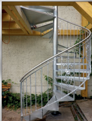
Außenspindel verzinkt, gekantete Blechstufen
