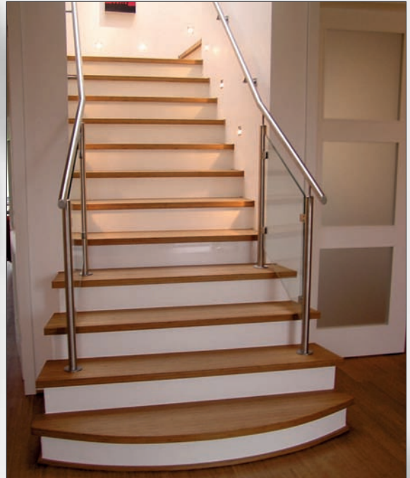
Zweiholmtreppe geschlossen, Stufen Buche multiplex, Setzstufen weiß lackiert, Edelstahlgeländer mit Glasfüllung
