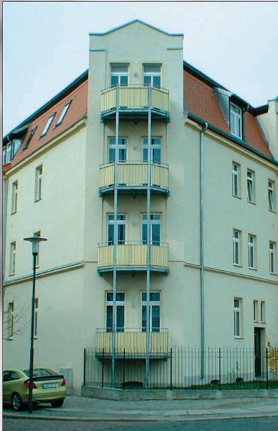
Balkonanlage, Granit mit Sichtschutz
