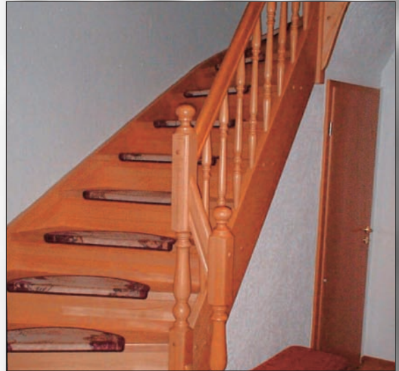
OG – Buchentreppe mit Einlage
