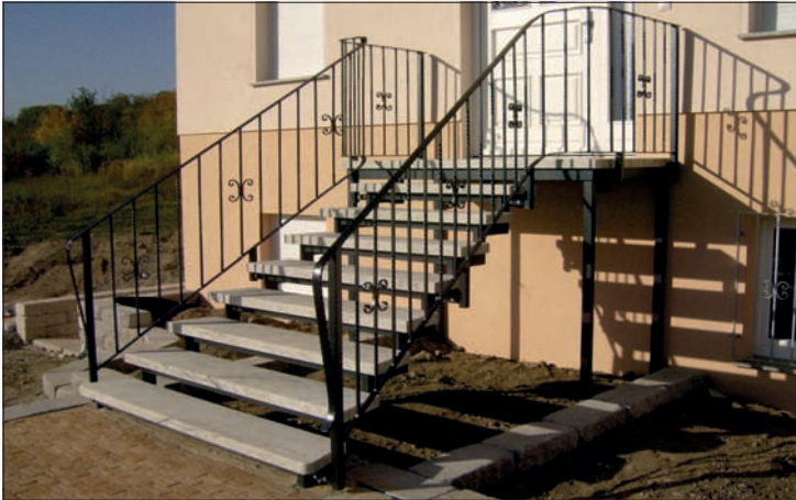
Außentreppe pulverbeschichtet mit Granitstufen
