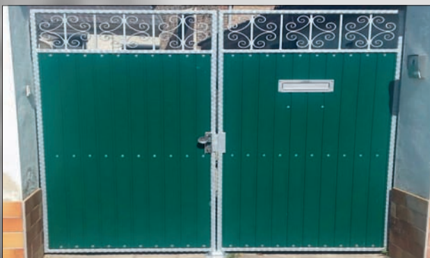
Tor mit Kömpanfüllung und integriertem Briefkasten
