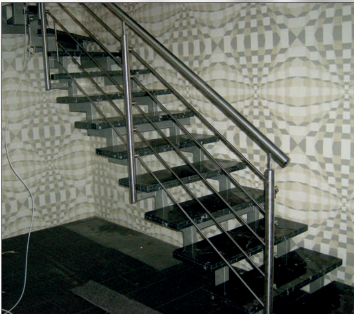
Stahlwangen Edelstahloptik lackiert, mit Granitstufen und Edelstahlgeländer
