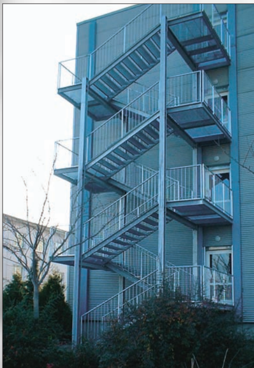
Fluchttreppe, Europa-Gymnasium Gommern
