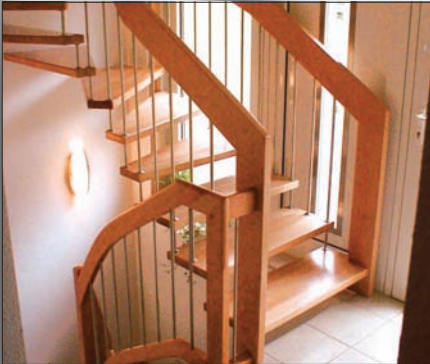
Bolzentreppe Buche, Edelstahlstäbe
