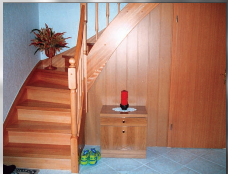
Buchentreppe mit seitlicher Verkleidung und Tür vor KG
